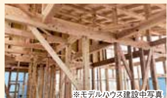
※モデルハウス建設中写真
