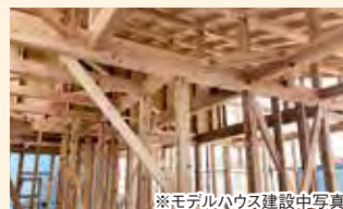
※モデルハウス建設中写真
