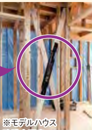
※モデルハウス 建設中写真
